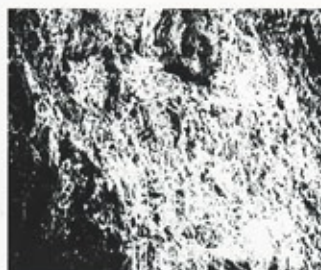
処理後のコンクリート表面拡大写真 (200倍率)
